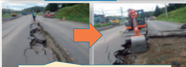
道路縦断方向に大きなクラックや陥没が発生
