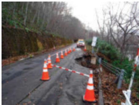
路面水が集中した箇所が侵食を受け被災
