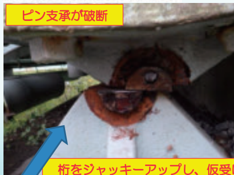
A2 支承の水平変位（45mm）
