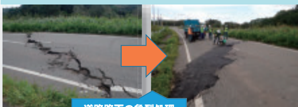
道路路面の亀裂処理
