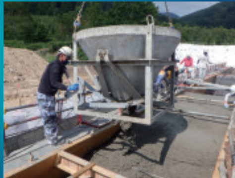
コンクリート打設
