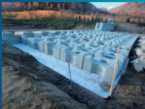
魚道ブロック設置完了
