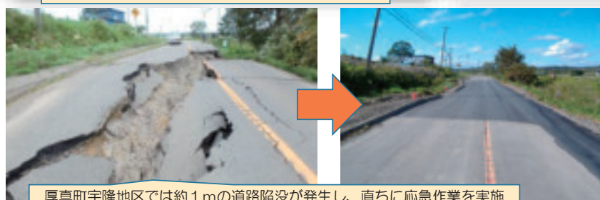
厚真町宇隆地区では約1mの道路陥没が発生し、直ちに応急作業を実施
