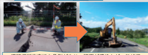
道路横断方向にも亀裂が生じ、路面が盛り上がった状況
