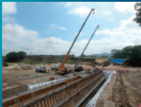
2班体制によるコンクリート打設
