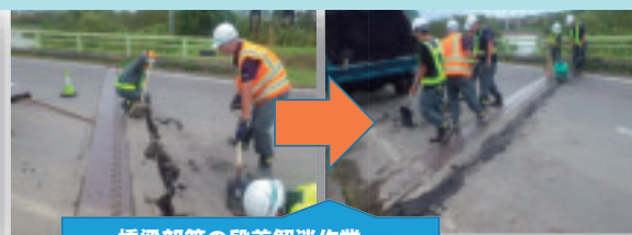
橋梁部等の段差解消作業。
