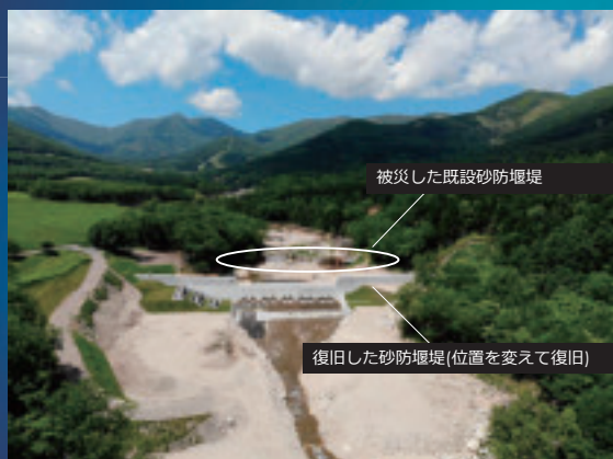
1号砂防堰堤復旧
