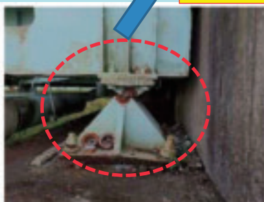
A2 支承の破断および遊間減少
