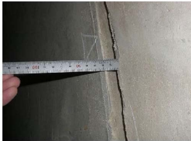
付図-1.10 目地部、打継ぎ目部の段差の例
