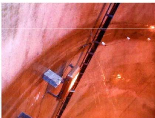
付写真-1.7 漏水（噴出）している
