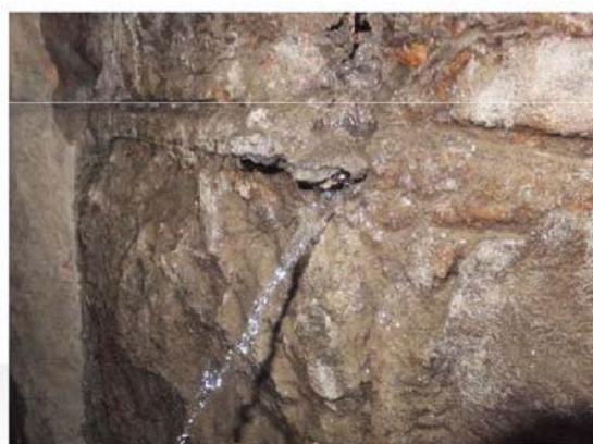
付写真-1.7 漏水（噴出）している
