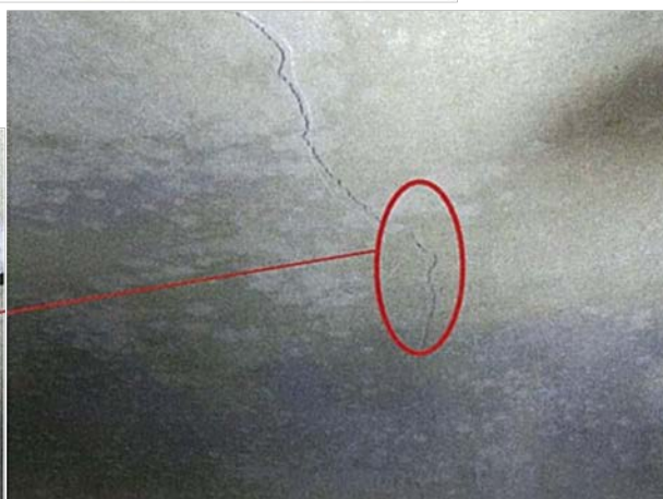
付写真-1.4 覆エスパンの中間付近に発生したひび割れの例
