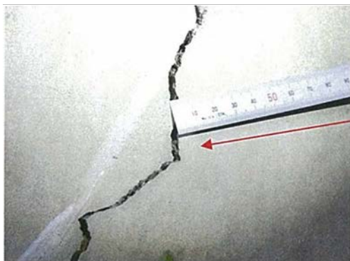
付写真-1.4 覆エスパンの中間付近に発生したひび割れの例
