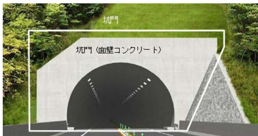
図-6.3 標準的な点検対象箇所（トンネル坑口部）
