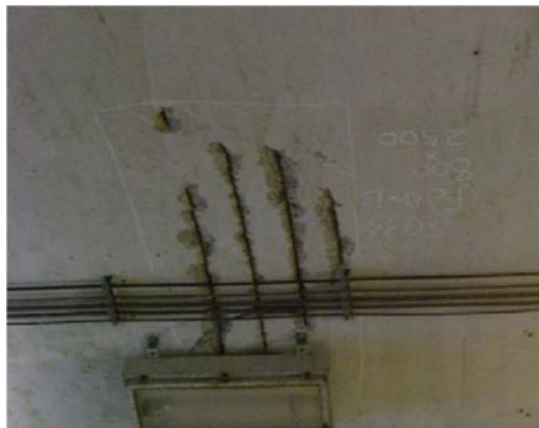
付写真-2.2 ひび割れ、はく落が見られ鉄筋が露出している例
